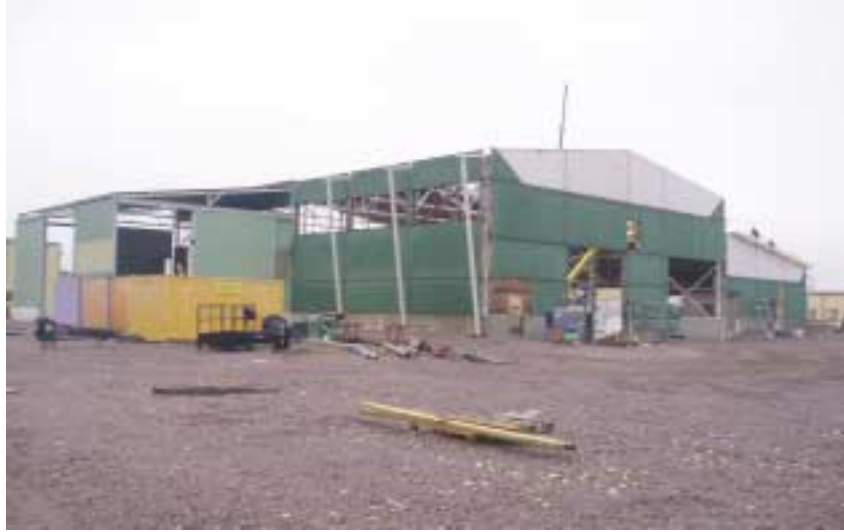
Hallin seinäelementit odottavat uutta peltipintaa
