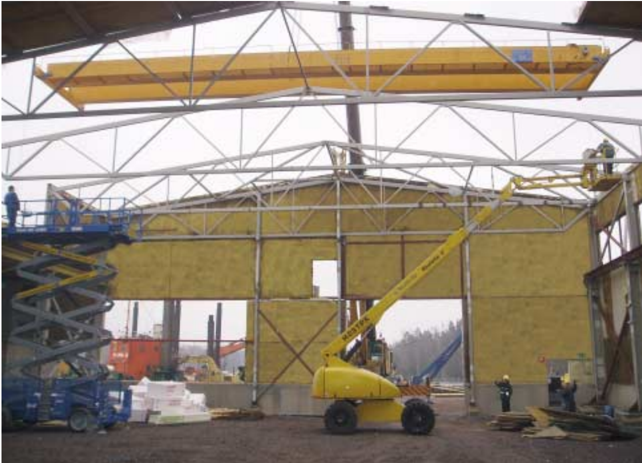
10 tonnin hallinosturi asennetaan paikoilleen
