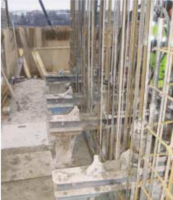
Tunkkirivi pystyraudoituksen välissä
