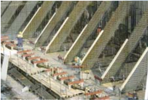
Liukuvalumuotin asennus
