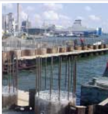
Naantalin Ro - Ro laituri s. 10-11
