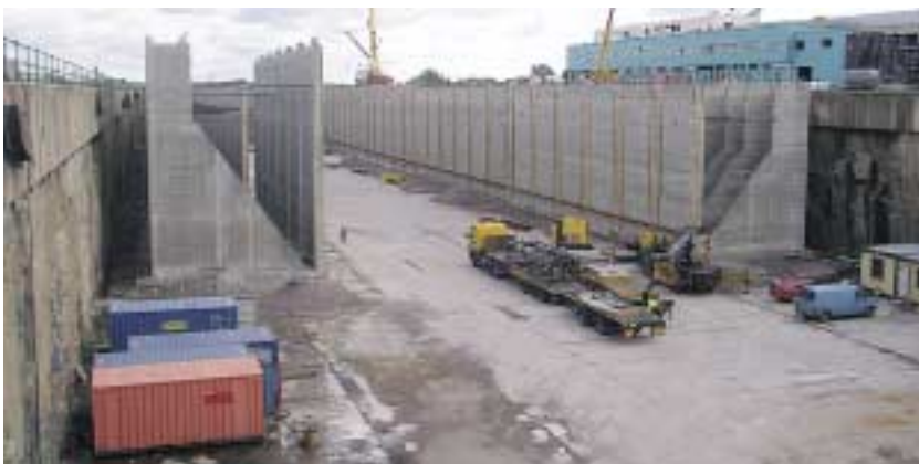
Valmiita elementtejä telakka-altaassa
