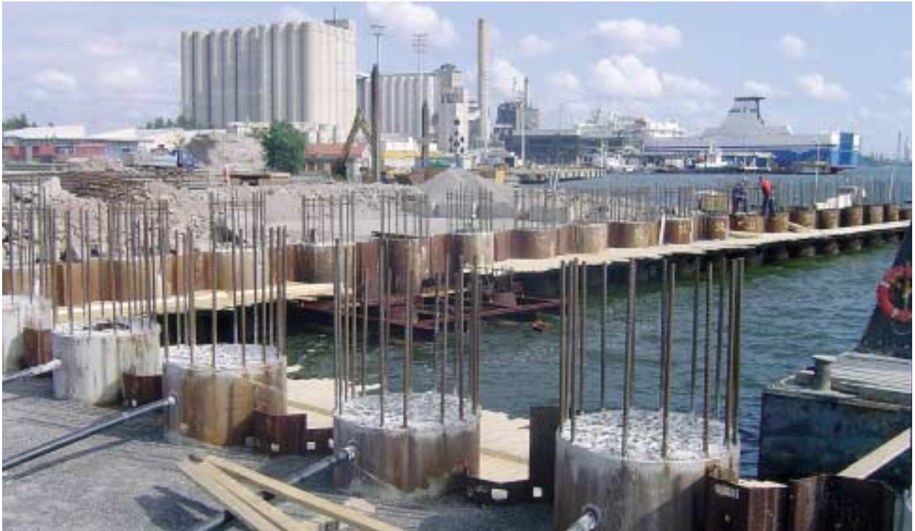
Reunapalkin muottityöt käynnissä
