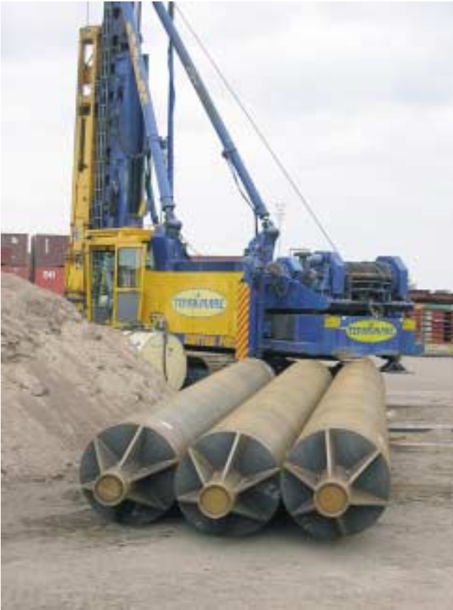
Junttan PM 25 ja asennusvalmiita paaluja.
