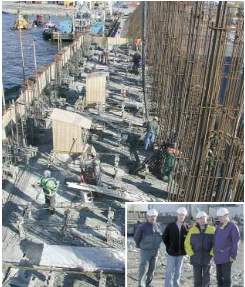
Laiturielementtien liukuvalu käynnissä
