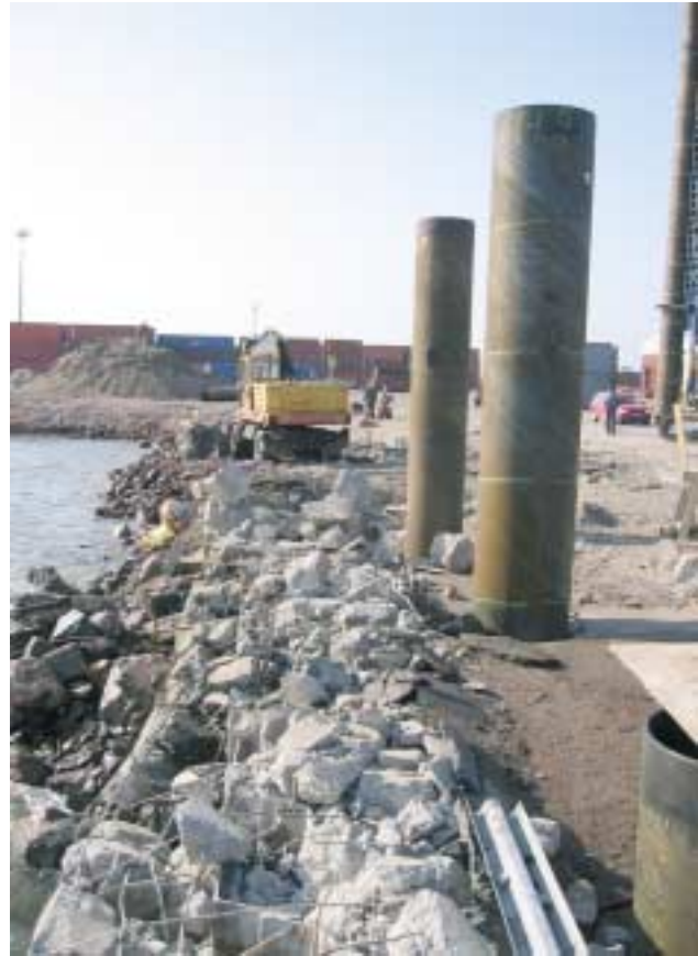
Lyödyt teräspuutkipaalut.
