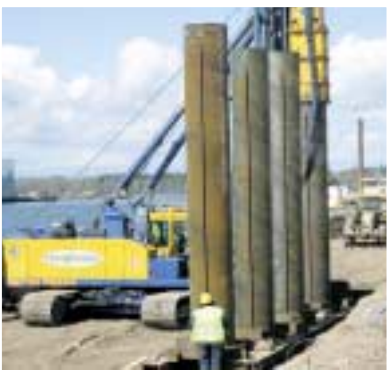
Putkiponttiseinän asennus käynnissä
