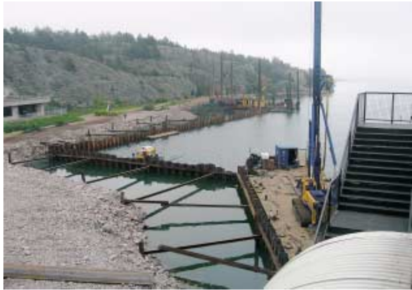
Laiturin ponttiseinän lyönti käynnissä
