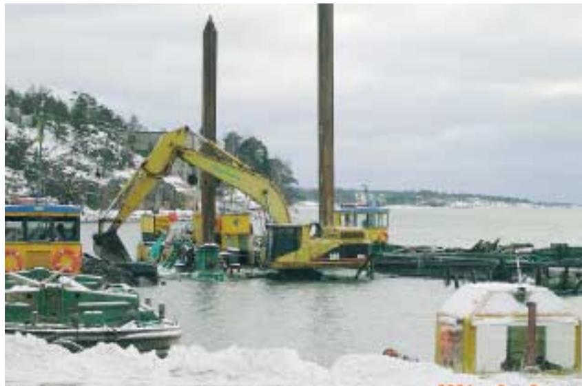
Satama-altaan pintakerroksen ruoppaus
