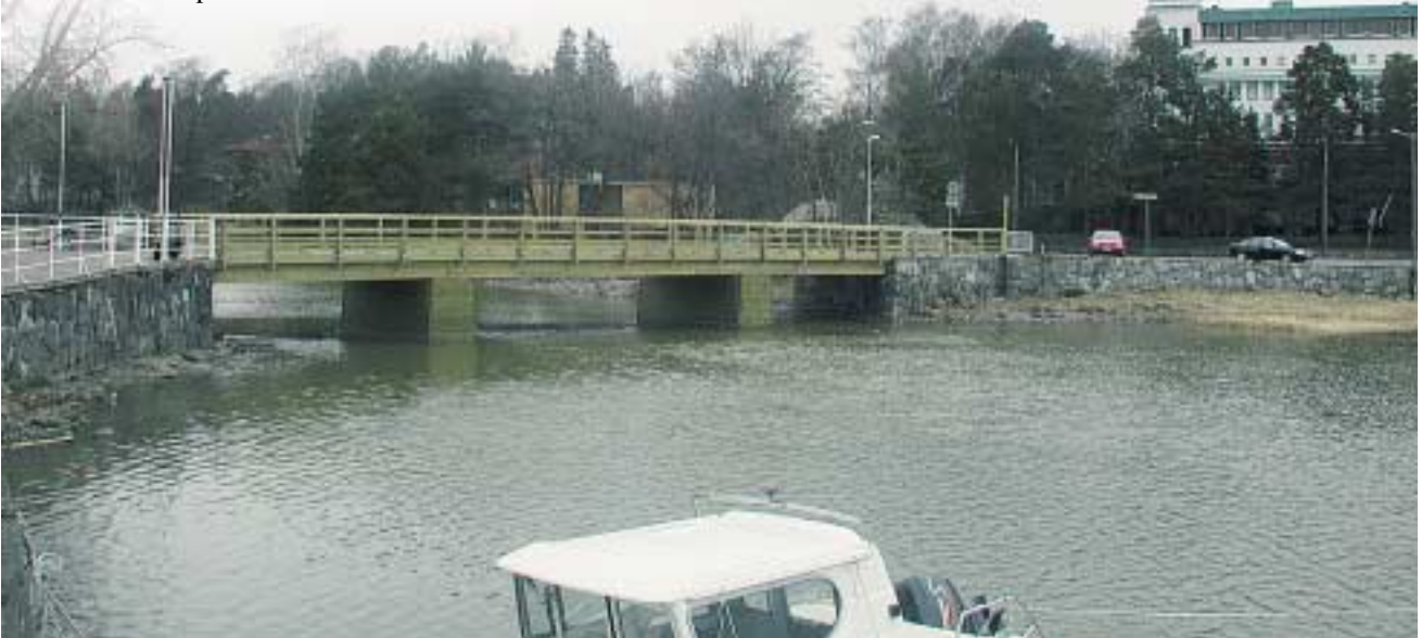
Valmis silta toukokuussa
