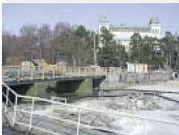
Kulosaaren Casinon siltatyömaa s. 6
